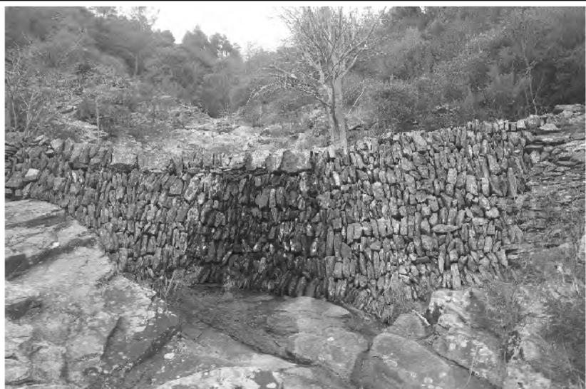
Saint-Melany (Ardèche) : clavade en plaques de schiste barrant le lit d'un ruisseau. Cet ingénieux aménagement hydraulique (appelé "tanca" en occitan) permet de freiner l'eau durant les grosses pluies, et de récupérer la terre issue de l'érosion des sols, afin de le remonter sur les terrasses.
